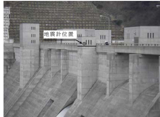
写真-5.8 久婦須川ダム下流面と天端地震計設置位置
