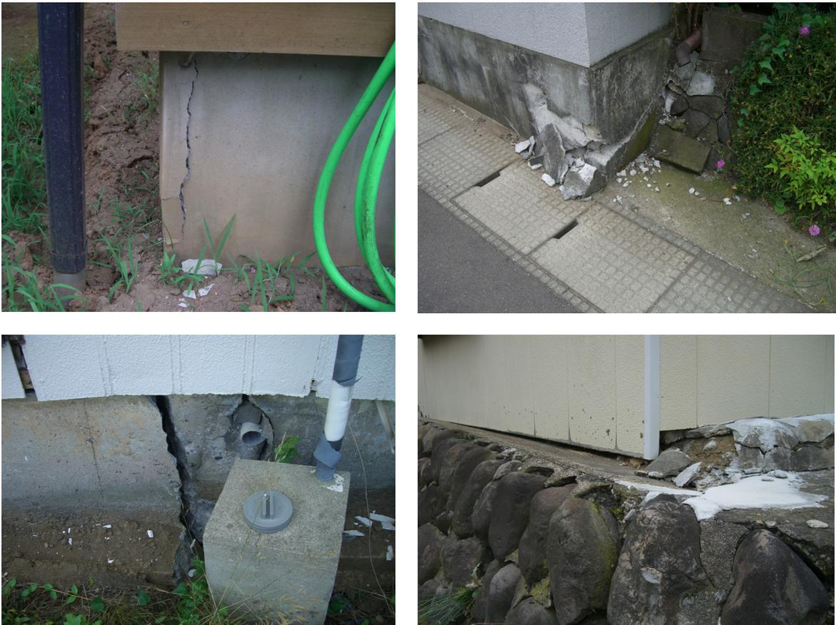
写真-8.28 基礎構造の被害例
