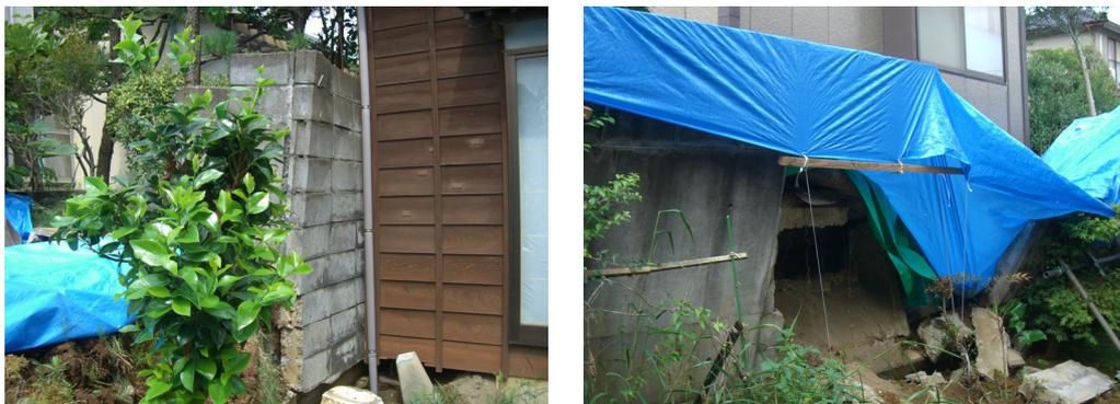
写真-8.21 増し積まれた擁壁の被害例
