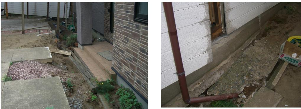
写真-8.20 宅地内の地盤の陥没や水平変位による住宅の被害
