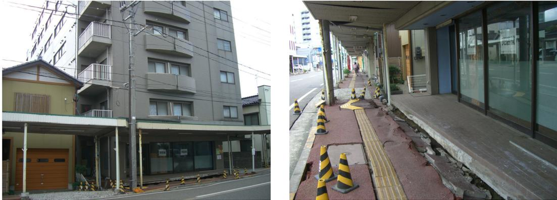
写真-8.24 杭基礎建物の被害（最大 500 程度の建物の相対的な浮き上がり）
