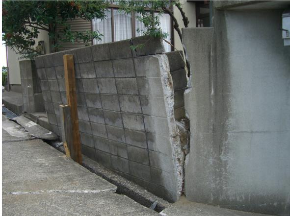
写真-8.4 ブロック塀による土留め擁壁の崩壊
