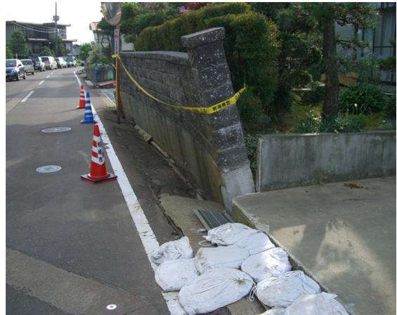
写真-8.18 山本団地における擁壁の被害例
