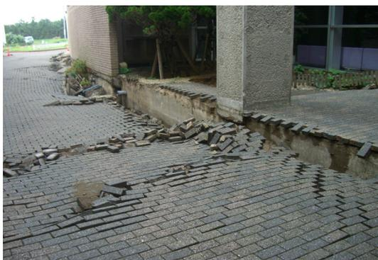
写真-8.30 建物周辺地盤の陥没
