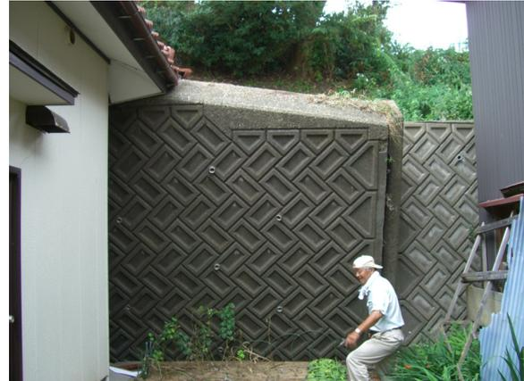
写真-8.5 ブロック積み擁壁の転倒例
