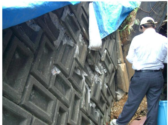
転倒部分に隣接する擁壁の壁体の破壊状況
