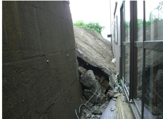
写真-8.11 モルタル吹き付け壁面の崩壊
