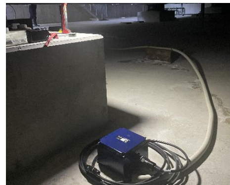
写真 2 いわき市庁舎免震層への加速度計の増設状況
