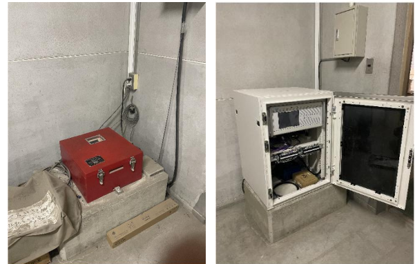
(a) 更新前 (b) 更新後 写真 1 いわき市庁舎の地震観測装置の更新状況
