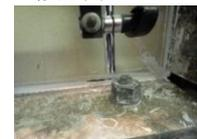
図3 下梁との取り付け部のシールの切れ
