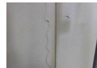
図2 写真2 ボードの縦方向のひび
