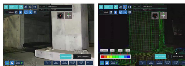
図10 大型ロボットPCの遠隔臨場による柱の傾き調査
