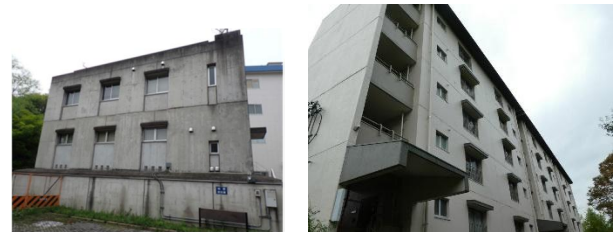
図 1 調査建物 A および調査建物 B の外観
