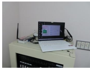
被災状況判定表示システム
