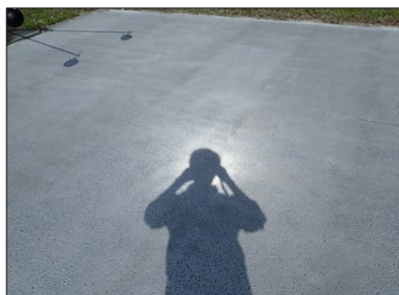
写真1 再帰性塗料を塗布した路面 (太陽光を背にして撮影)
