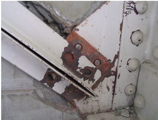
写真 6.17 ブレース材端部ボルト破断、ボルト孔変形(44) 写真 6.18 ブレース材座屈(46)
