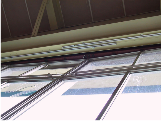
写真 6.104 南側妻面開口部サッシはらみ出し 写真 6.105 サッシを留めていたと思われる 金具
