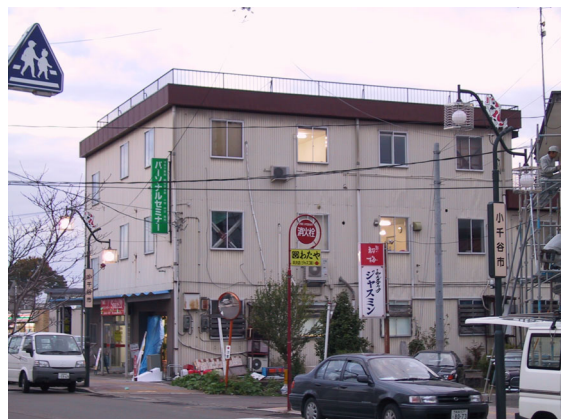
写真 6.119 鉄骨造3階建て 特段の被害なし
