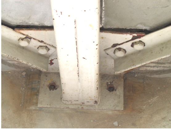
写真 6.15 間柱脚部ボルト破断、ずれの跡(39) 写真 6.16 ブレース端部ボルト破断、ボルト孔変形(42)
