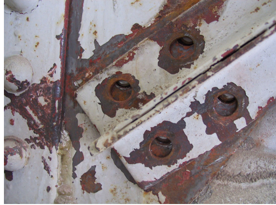
写真 6.15 間柱脚部ボルト破断、ずれの跡(39) 写真 6.16 ブレース端部ボルト破断、ボルト孔変形(42)
