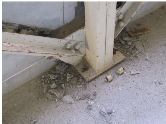
写真 6.74 ブレース材つづり部の亀裂(56)
