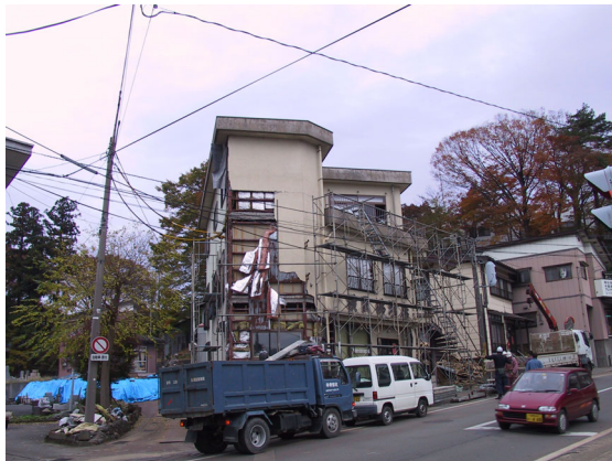
写真 6.116 外装材脱落
