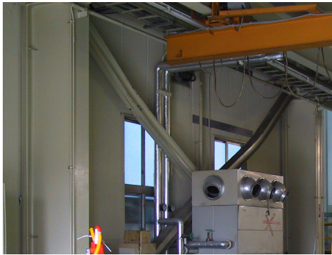
写真 6.111 ブレース材座屈
