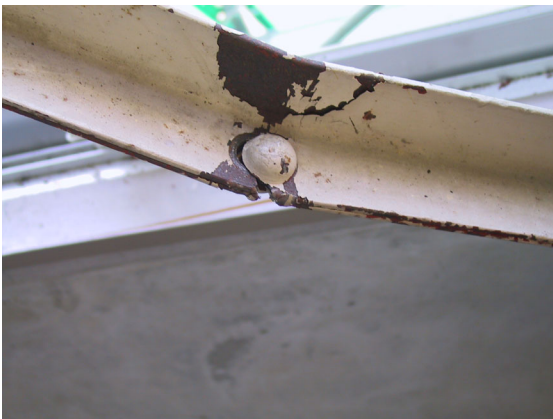
写真 6.74 ブレース材つづり部の亀裂(56)
