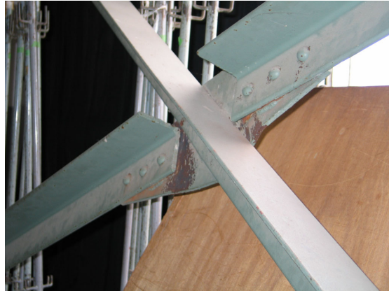
写真 6.134 ガセットプレートの塑性化
