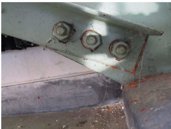
写真 6.44 ブレース材端部(130)
