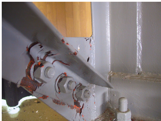
写真 6.36 ブレース材端部(123)
