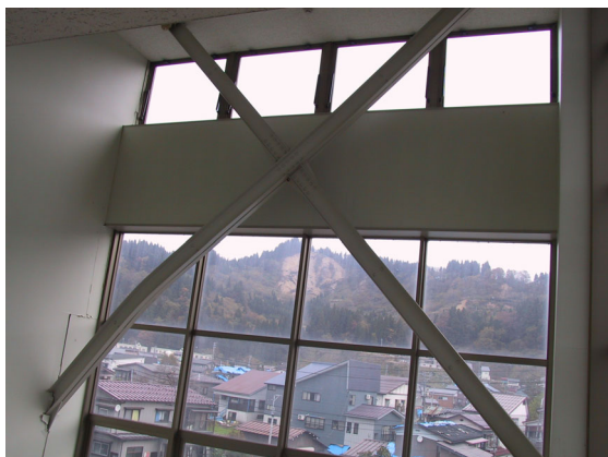
写真 6.83 ブレース材の座屈(40) 写真 6.84 ブレース材の座屈(43)
