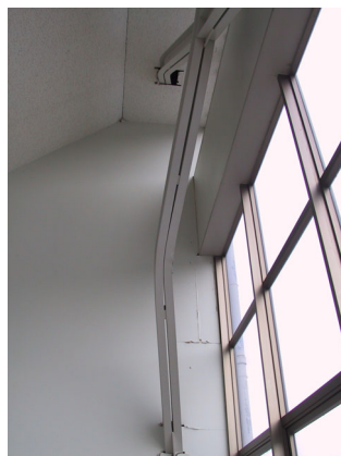
写真 6.83 ブレース材の座屈(40) 写真 6.84 ブレース材の座屈(43)
