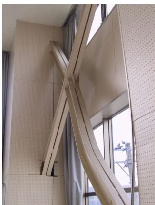
写真 6.85 ブレース材の座屈(47)
