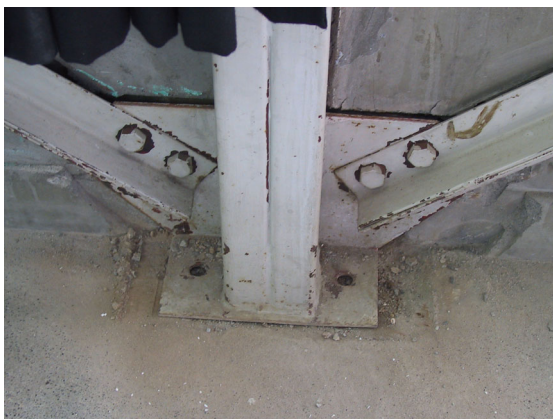
写真 6.19 間柱脚部ボルト破断、ずれの跡 (47) 写真 6.20 ブレース材端部ボルト破断 (50)
