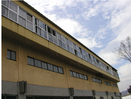
写真 6.136 体育館外壁および窓の状況
