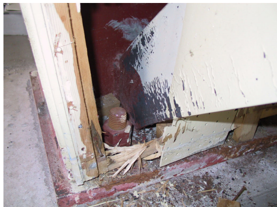
写真 6.103 ブレース材脚部(126)
