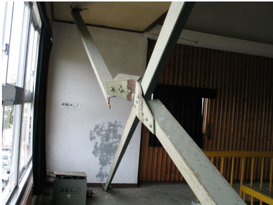
写真 6.133 リベット孔欠損部からのブレース材の破断及びガセットプレートの座屈
