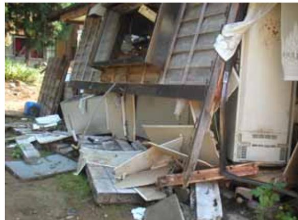
写真 5-104 ブロック基礎の立ち上がり部分の崩壊
