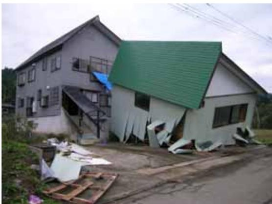
写真 5-21 作業小屋の倒壊
