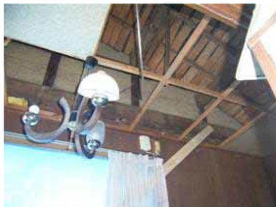
写真 5-96 天井材の脱落
