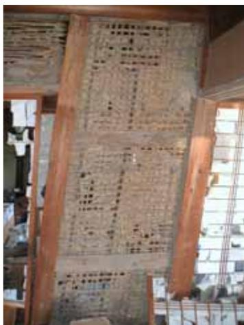
写真 5-83 塗り土が崩落した土壁
