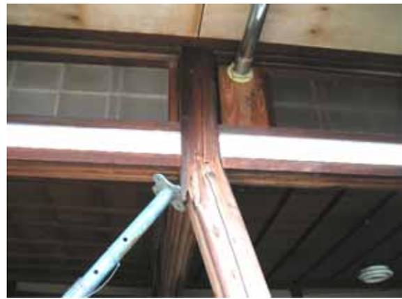
写真 5-66 折損した柱
