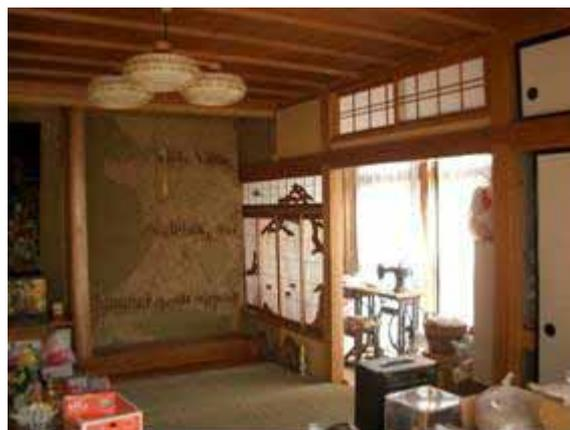
写真 5-74 土壁（内部に筋かい）の被害
