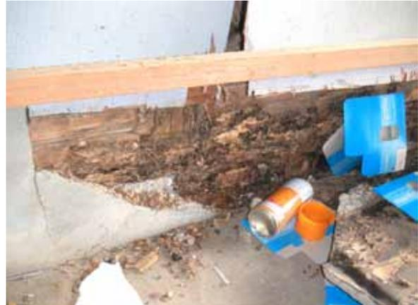
写真 5-86 腐朽し、蟻害を受けた土台
