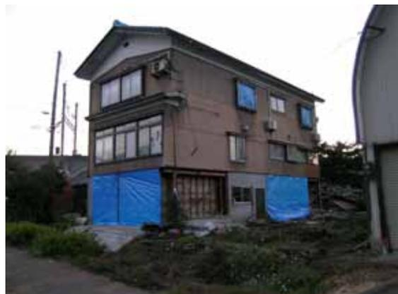
写真 5-32 1 階 S 造 2,3 階木造の住宅の被害
