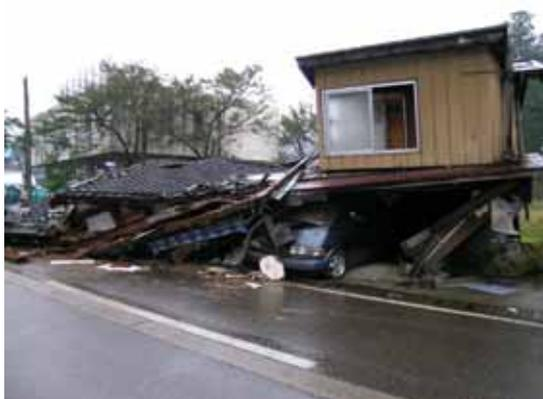
写真 5-37 竜光地区の倒壊した住宅
