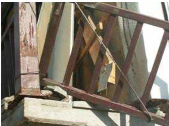
写真 5-91 二つ割り筋かいと筋かいプレート
