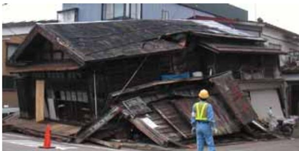
写真 5-2 比較的古い構法の木造家屋の倒壊
