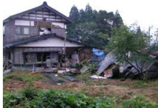
写真 5-18 住宅の平屋部分倒壊
