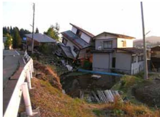
写真 5-36 地盤崩壊に伴う住宅倒壊
