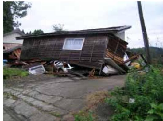
写真 5-20 車庫の倒壊
