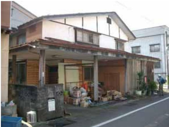
写真 5-97 建物概観（モルタル剥落）
