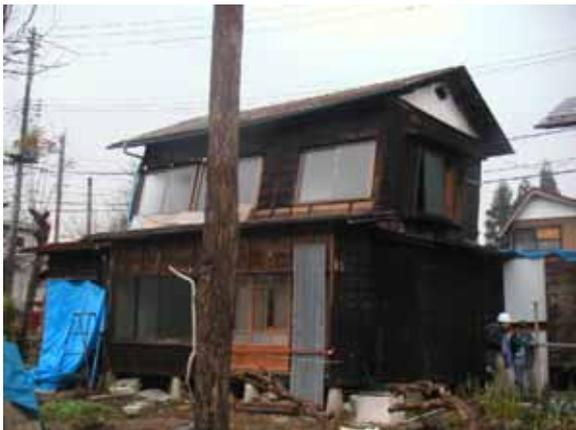
写真 5-123 残留変形の大きな家屋
