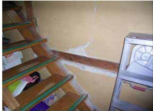
写真 5-114 内壁の被害
