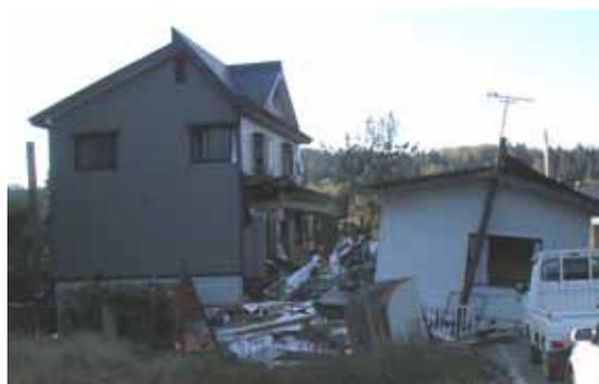
写真 5-28 連結部が解離して倒壊した作業所
