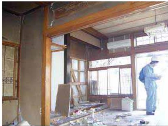
写真 5-78 内壁の被害と筋かい
