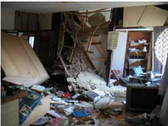
写真 5-103 内壁の脱落
