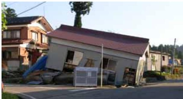
写真 5-25 作業小屋の倒壊
