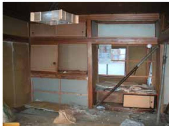
写真 5-53 内装ラスボードの脱落
