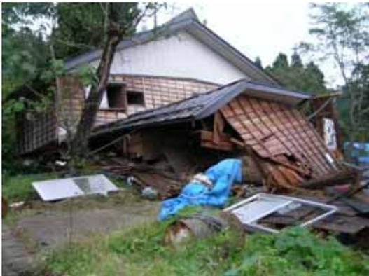
写真 5-19 住宅の1階層崩壊
