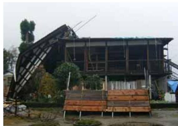
写真 5-10 木部2階が崩落した高床式木造（1層はRC造）
