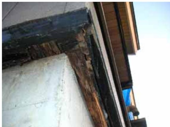
写真 5-51 水回り付近の土台の腐朽
