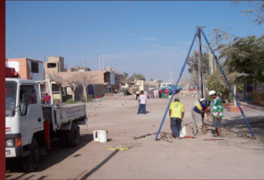
Sondaje S-2, ubicado en la calle Prolongación Arequipa - Pisco
