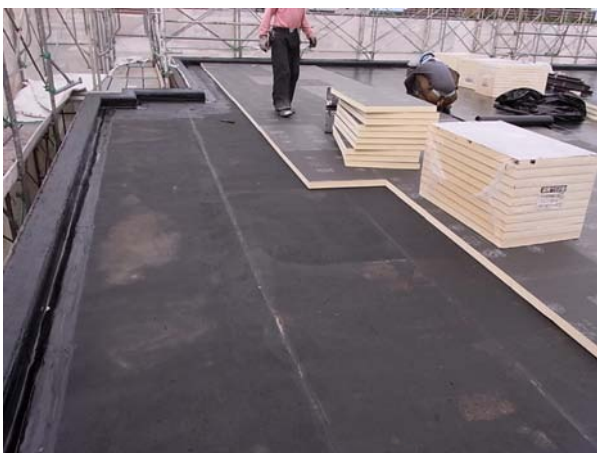
屋根スラブ 断熱防水工事
