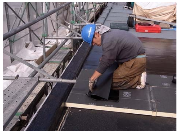
屋根スラブ 断熱防水工事
