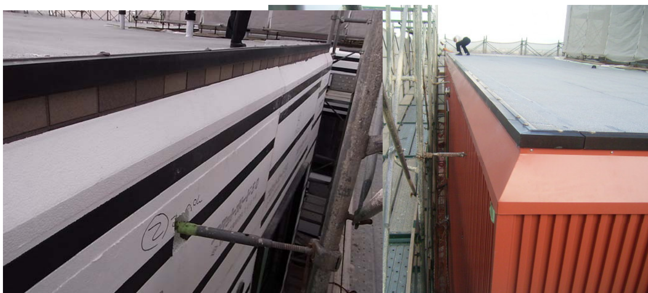
外壁上部の斜め笠木
